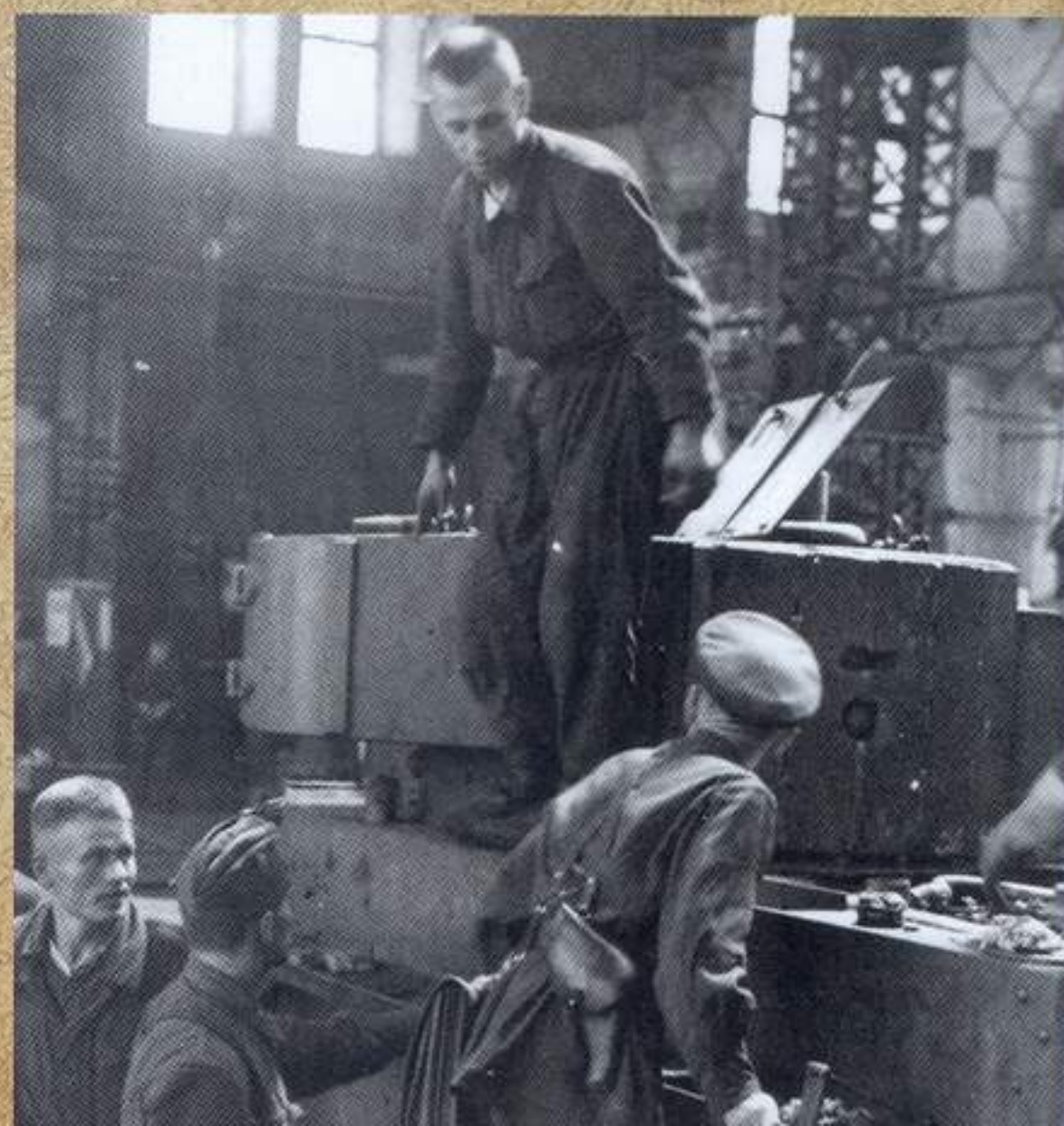
★ Ремонт танков в осажденной Одессе. У этого БТ-7 стальными полосами усилена лобовая броня башни. 1941 год.
